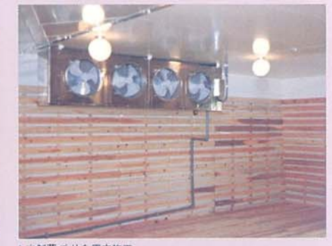
▲木製荷下りを庫内施工
