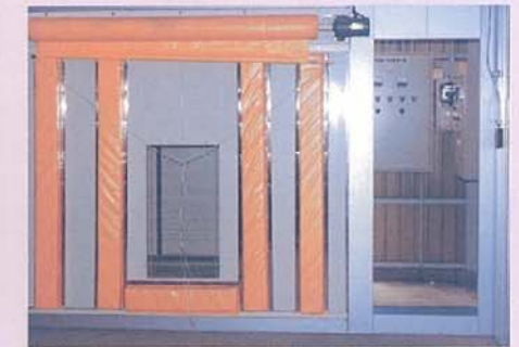
▲差圧式予冷库内部
